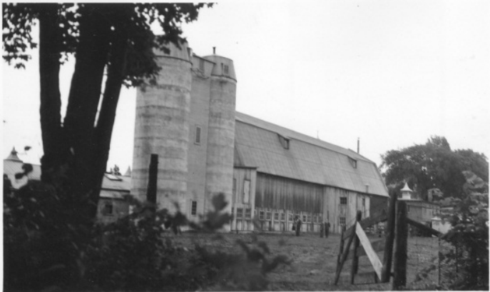
21. Ferme Mont-de-La Salle
